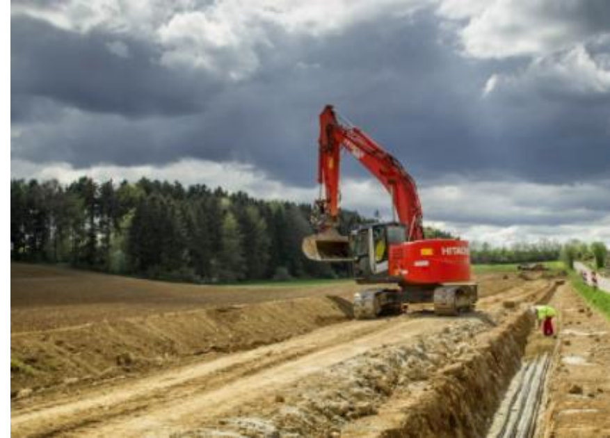
Gleichstrom-Erdkabel-Verlegung
